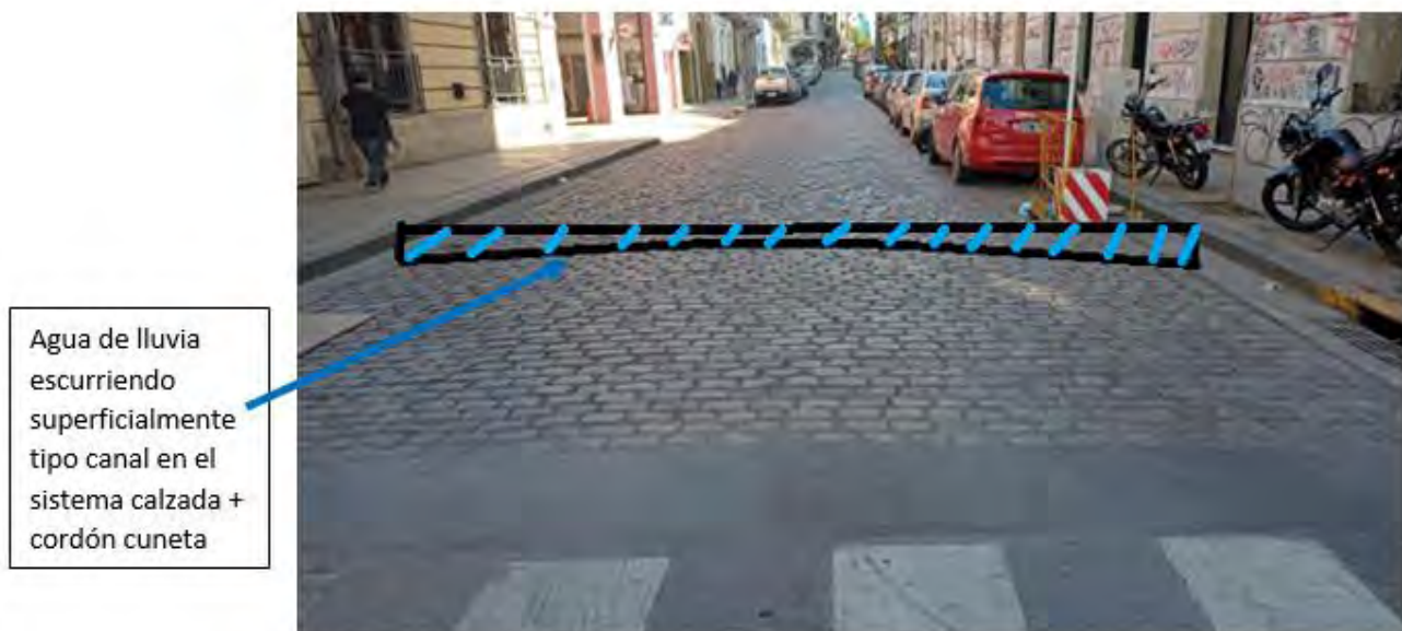
Figura 9. Revancha del sistema pluvial utilizando la calzada y el cordón cuneta para el escurrimiento del agua de lluvia. Bolívar y Carlos Calvo
