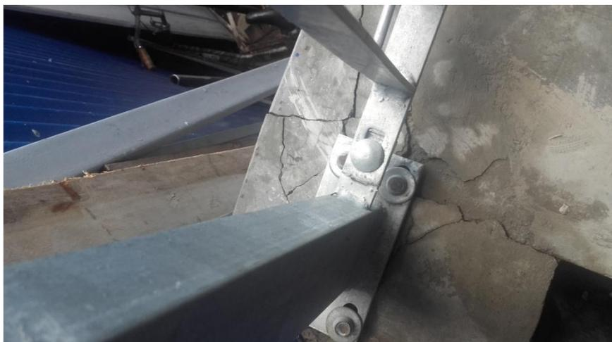
**Figura 9.** Detalle de fisuras en el sector de sujeción de las barandas.
