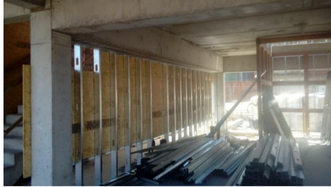
Figura 6. Vista del sistema de muros en uno de los departamentos adyacentes al núcleo de escaleras.
