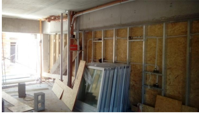
Figura 5. Interiores de los muros con instalaciones.
