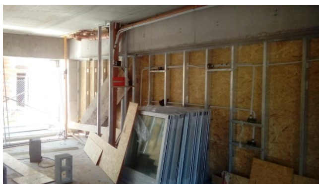
Figura 5. Interiores de los muros con instalaciones.
