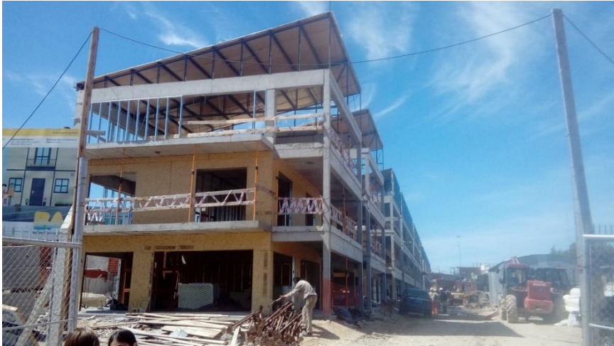
Figura 1. Vista general del conjunto habitacional en donde puede observarse el grado de avance actual, los paneles interiores y parte de los paneles exteriores a los que se les colocará aislante y tendrán como revestimiento la chapa acanalada azul. La recova de planta baja es por partes pública, y por otras privada y de las viviendas.
